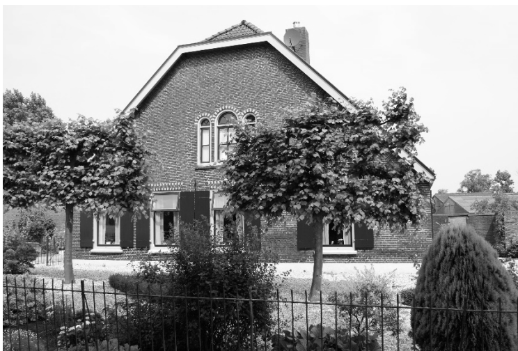
De in 1883 gebouwde boerderij Grijpenstein in Tull en 't Waal op de plek van het vroegere versterkte huis.
